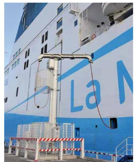
Potence avec le câble électrique de 11 000 volts à brancher à l'intérieur du bateau.
